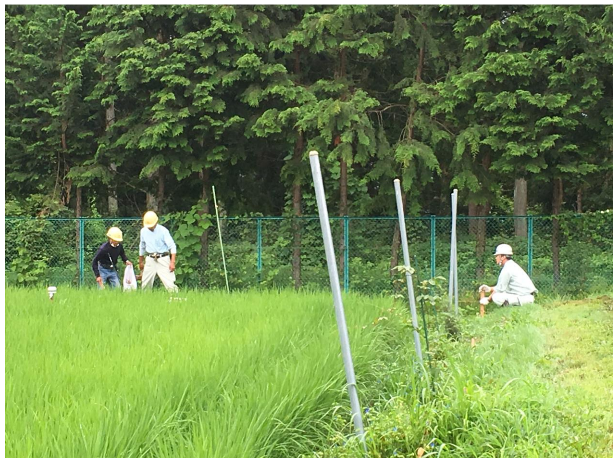
防雀網支柱補強 平成28年7月28日
